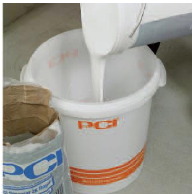
Добавить жидкий компонент PCI Seccoral 2K Rapid
