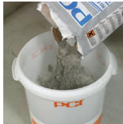
Засыпьте сухой компонент PCI Seccoral 2K Rapid в ёмкость
