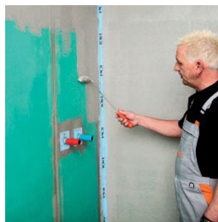
Затем производите нанесение гидроизоляционного покрытия по всей площади обрабатываемой поверхности.
