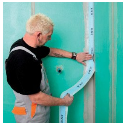
Вручную выровняйте гидроизоляционную ленту PCI Pécitape 120 и слегка надавите...
