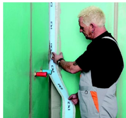
Гидроизоляционная лента PCI Pecitape встраивается во влажный слой используемого гидроизоляционного материала
