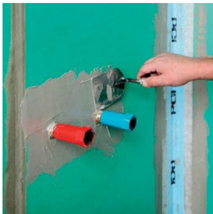
Перед монтажом гидроизоляционного воротника PCI Pécitape 10x10 также нанесите достаточное количество гидроизоляционного материала вокруг выходов водопроводных труб.
