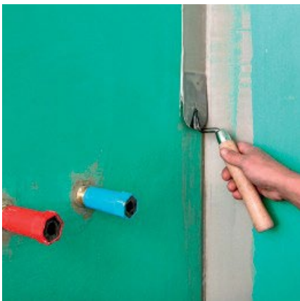
Перед закреплением гидроизоляционной ленты нанесите достаточное количество гидроизоляционного материала.
