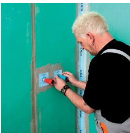
... затем аккуратно наденьте гидроизоляционный воротник на заглушку выхода водопроводной трубы ...
