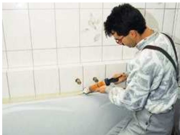
Эластичное уплотнение швов с помощью PCI Silcoferm VE; цветовая гамма герметика соответствует цветовой гамме раствора для затирки швов.
