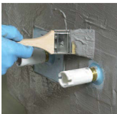
Используйте гидроизоляционную манжету в местах закладных деталей
