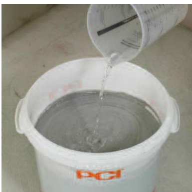
Добавить воды в готовую смесь
