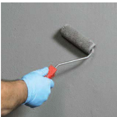
Нанесите на всю площадь первый слой гидроизоляции Seccoral 2K Rapid при помощи валика
