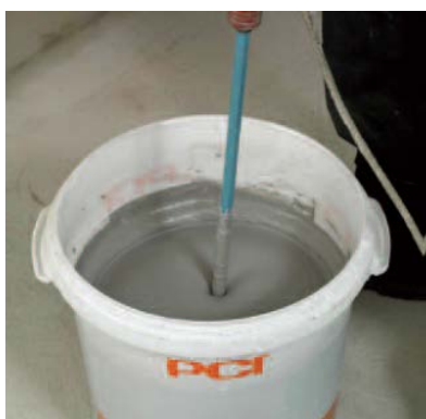
Перемешать оба компонента при помощи низкооборотистой дрели
