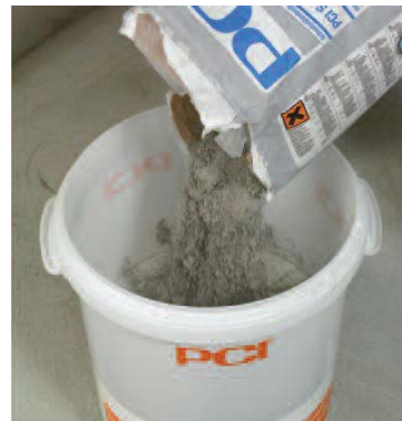
Добавить сухой компонент PCI Seccoral 2K Rapid в жидкий
