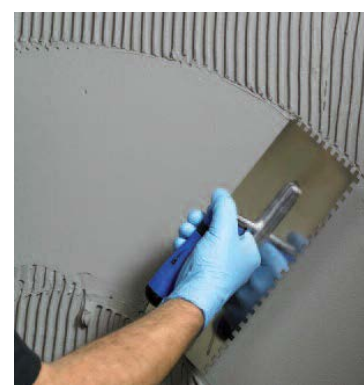
Нанесите второй слой гидроизоляции при помощи шпателя
