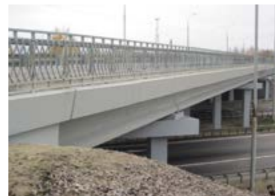
2011 год, Московская область, трасса М4, М5. Текущий ремонт более 20 искусственных сооружений, защита опор и пролетных строений MasterProtect 330 EI RAL 6019 и 7038.
