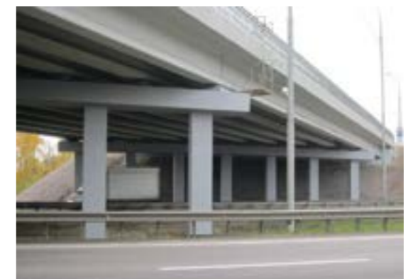
2011 г. Московская область, путепроводы на трассе М5, декоративная защита пролетных конструкций MasterProtect 330 EI RAL 6019, MasterProtect 330 EI RAL 7040 – опор.
