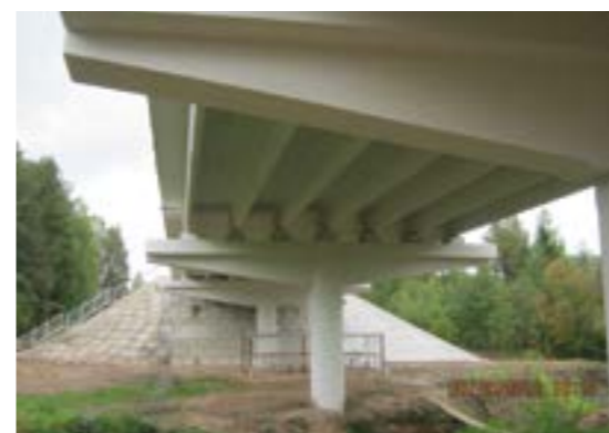
2013 год, Комплекс искусственных сооружений а/д Р-21 «Кола» СПб-Мурманск. Капитальный ремонт с защитой пролетных сооружений и опор MasterSeal 588 White.
