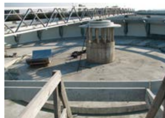
2009–2011 год, Калининград. Строительство городских очистных сооружений. Внутренняя гидроизоляция и защита вторичных и первичных отстойников, аэротенков
