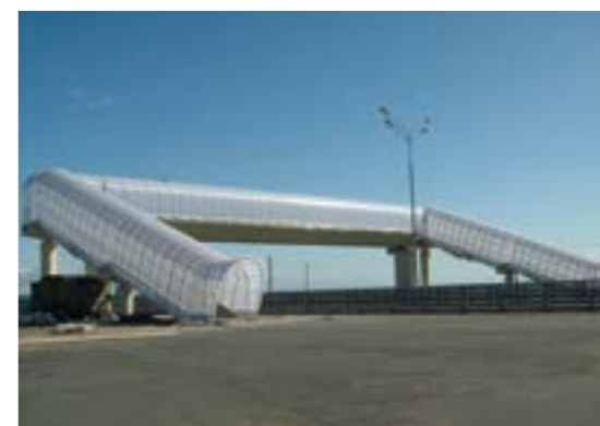
2008 год, Санкт-Петербург. Строительство Комплекса Защитных Сооружений от наводнений. Гидроизоляция напорной грани дамбы MasterSeal 588 Grey, защита жб поверхностей пешеходных переходов MasterProtect 330 EI RAL 1013, пролетных конструкций и опор путепроводов MasterSeal 588 RAL 7044.
