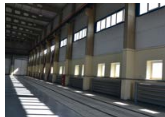
2011 год, Вагонное депо в г. Лабитнанги. Защита стен депо покрытием MasterProtect 320 RAL 1015.
