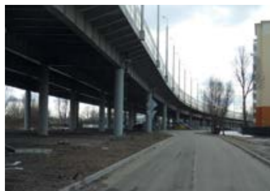
2012 год, Калининград. Строительство моста. Защитная декоративная окраска жб конструкций пролетных строений MasterProtect 330 EI RAL 7040, опор MasterProtect 320 RAL 1015 и лестничных и элементов MasterSeal 588 RAL 7044.
