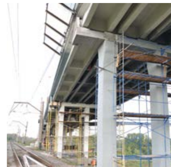
2008 г. Нижний Новгород, Борский мост через р. Волга. Нанесение защитного полимерцементного покрытия MasterSeal 588 на опоры и пролетные строения в ходе капитального ремонта сооружения.
