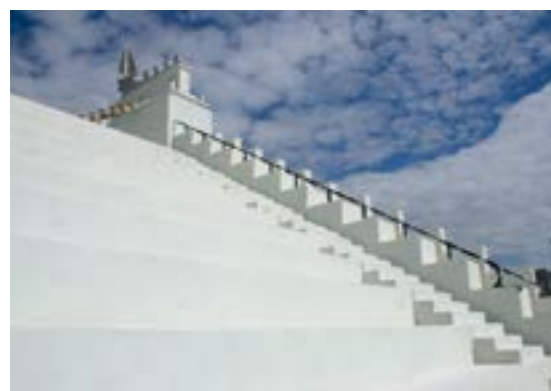
2008 год, Москва. Капитальный ремонт трибун Водного стадиона «Динамо». Гидроизоляционное и защитное покрытие трибун и фасадов покрытием MasterSeal 588 White.
