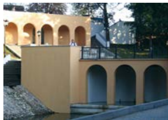
2012 г, Калининград. Декоративная защита фасадов водосборного сооружения между Верхним и Нижним Городскими прудами MasterProtect 330 EI RAL 1013
