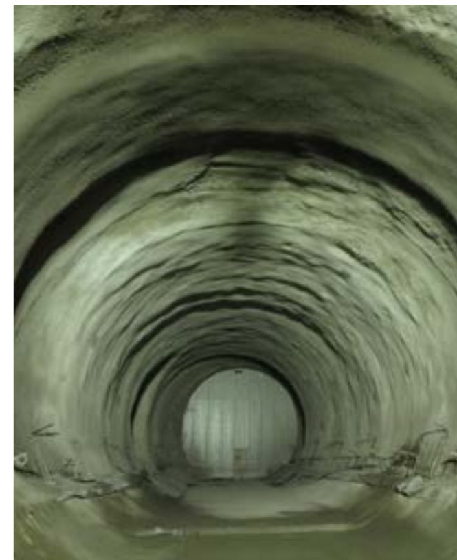
Постоянная обделка из набрызг-бетона с гидроизоляционной мембраной MasterSeal 345
