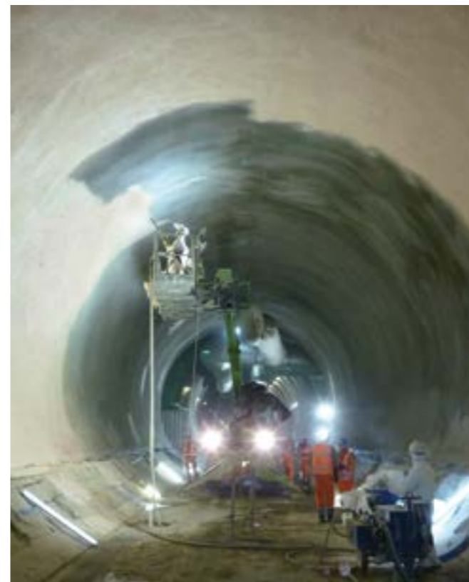
Нанесение гидроизоляционной мембраны MasterSeal 345
