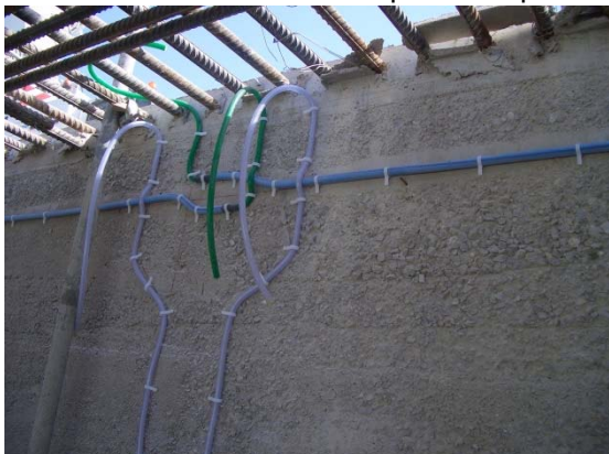
13. Установка системы на прямом отрезке
