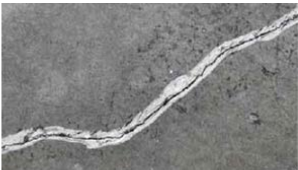
Рисунок 3. V-образная канавка вдоль трещины
