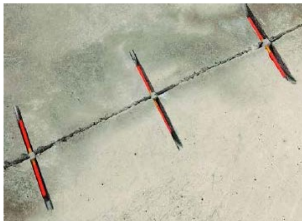
Рисунок 4. Установка стяжек в каналы, открытые в трещинах
