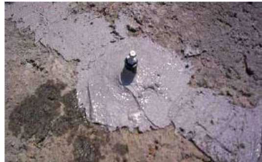
Рисунок 2. Герметизация пакера, установленного на поверхности и трещины при использовании соответствующего средства MasterInject.
