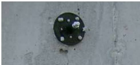
Рисунок 1. Размещение устанавливаемого на поверхности ниппеля по центру отверстия трещины.
