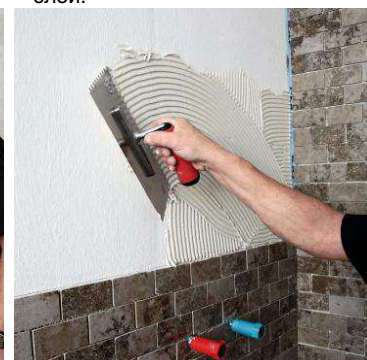
6. Когда водонепроницаемый PCI® Lastogum затвердел, можно укладывать плитку.
